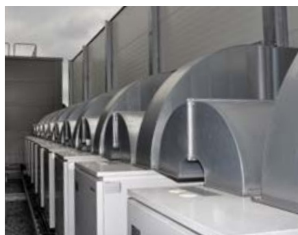
Hinter der Sichtwand: Zehn Luft-Wasser-Wärmepumpen WPL 23 cool von STIEBEL ELTRON.
