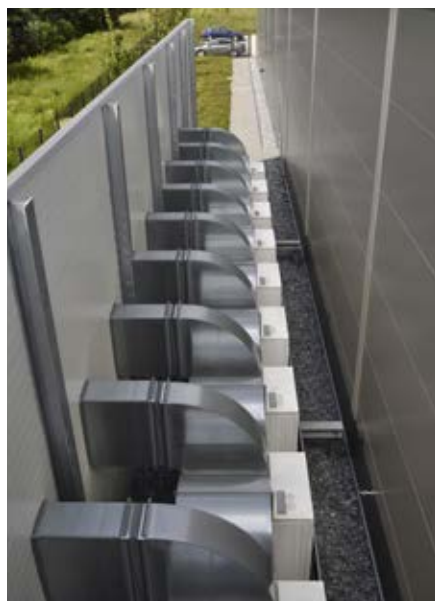
Hinter der Sichtwand: Zehn Luft-Wasser-Wärmepumpen WPL 23 cool von STIEBEL ELTRON.
